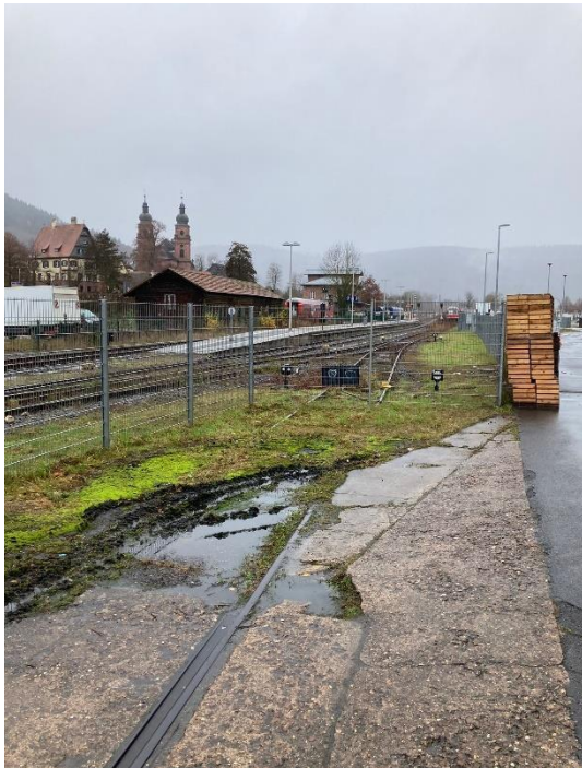
Anschlussweiche Bahnhof Amorbach- OWA Werksgelände
