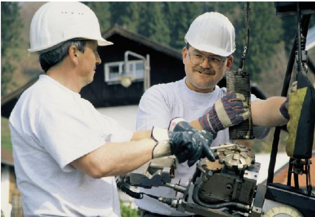
Abb. 12: Fräsroboter vor dem Einsatz im Kanal
