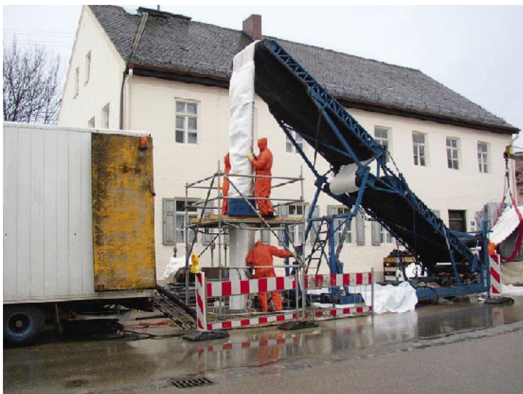
Abb. 26: Einbau des Schlauchliners über den Schacht in den Kanal
