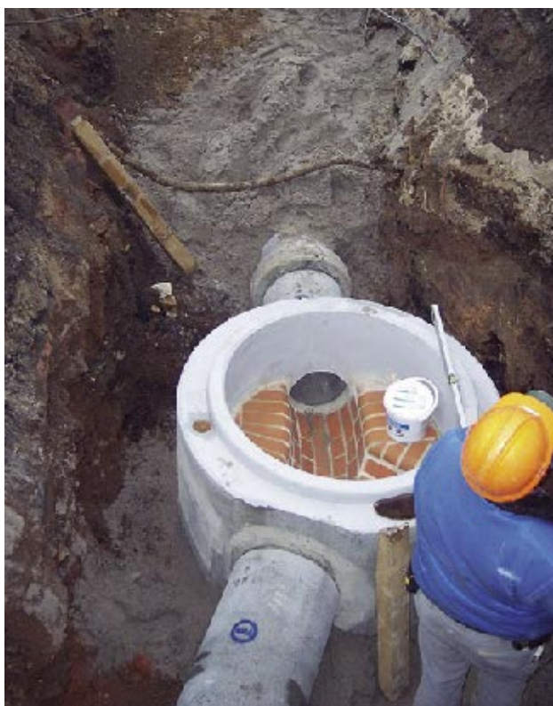
Abb. 28: Kanalerneuerung in offener Bauweise
