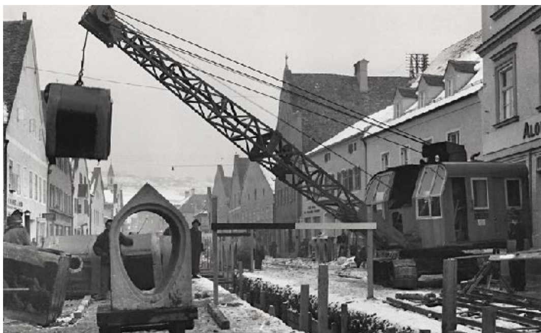
Abb. 5: Kanalbau in Kelheim 1952
