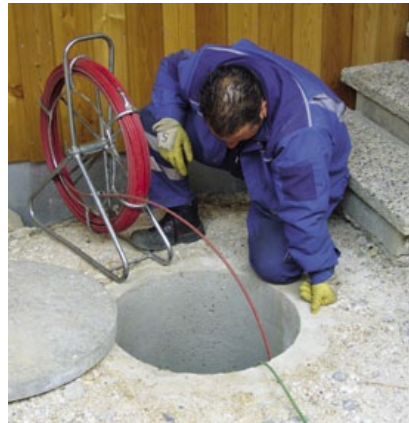
Abb. 30 und 31: Tragbare Schiebekamera zur Inspektion von GEA
