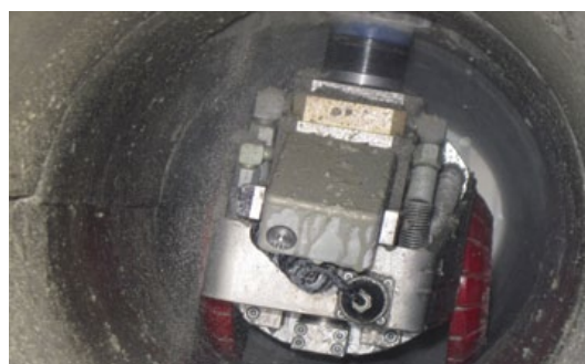
Abb. 25 (rechts): Roboter beim Spachteln
