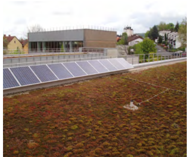
Pavillon-1 der Hefner-Alteneck-Schule Aschaffenburg
