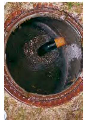
Abb.: Schacht aus Beton
