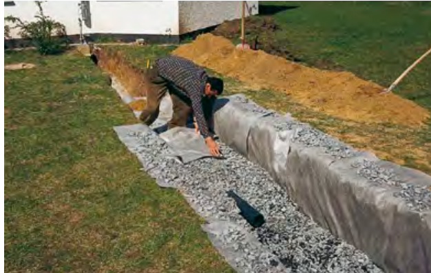
Abb. links: Anschluss des Versickerungsrohrs.
