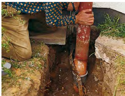
Abb. rechts: Anschluss an Hofablauf.
