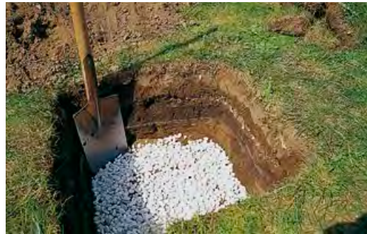
Abb. links oben: Ausheben der Grube.
