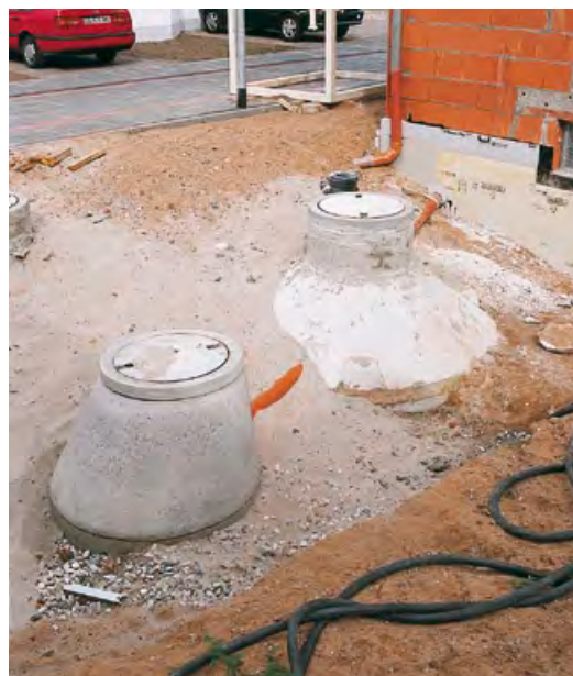
Abb.: Regenwasserspeicher kombiniert mit Versickerung.
