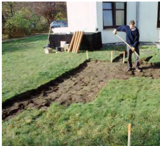
Abb. links: Abstecken der Baugrube.
