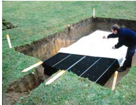
Abb. links: Einsetzen der Kunststoffelemente.
