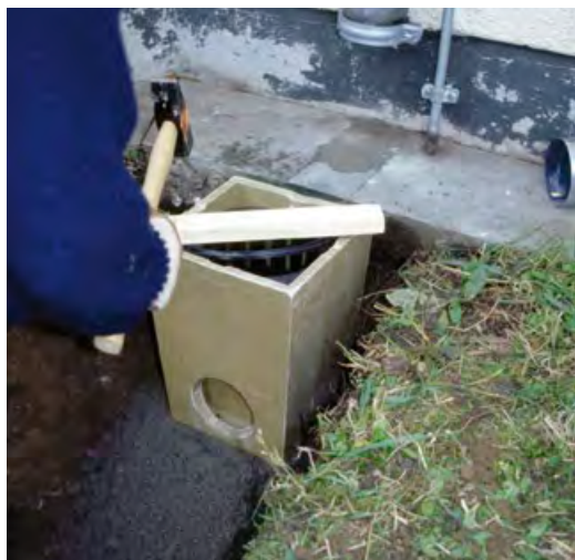
Abb. rechts: Rigolenbereich ausheben.
