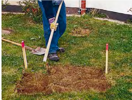
Abb. links: Abstecken der Baugrube.
