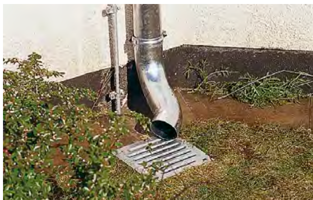
Abb. links: Mutterboden auffüllen und Rasenschollen ergänzen.
