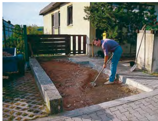
Abb. links: Randsteine setzen.
