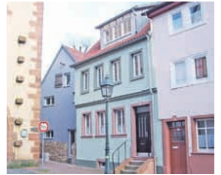
Barbara Stute: Miltenberg, Hauptstraße 5, Umbau und Erweiterung
