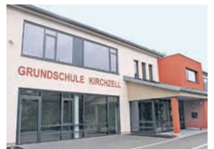
Gemeinde Kirchkzell, Sanierung und Umbau der Grundschule
