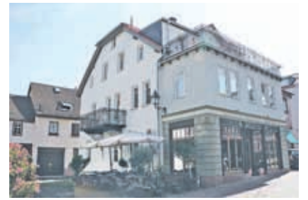
Monika und Johannes Oswald: Miltenberg, Ankergasse, Ergänzung eines neuen Balkons, weitgehende Weiterverwendung der vorhandenen Bauteile
