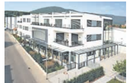
Mainmetall: Firma Mainmetall, Miltenberger Straße, Bürgstadt, Neubau Zentralverwaltung
