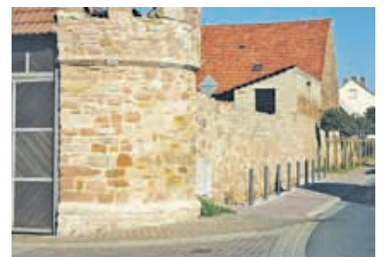
Markt Sulzbach, Instandsetzung der Ortsmauer aus dem 17. Jahrhundert.
