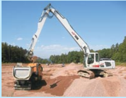
Rückbau des Porphyrschotters der Entwässerungsschicht
