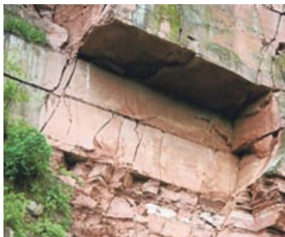
Vier offen gelassene Buntsandstein-Brüche werden unter dem Motto „Buntsandstein – Erlebnis für alle Sinne“ sichtbar gestaltet.
