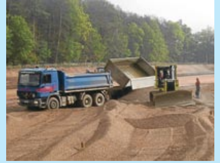
Anlieferung und Einbau Entwässerungsschichtmaterial
