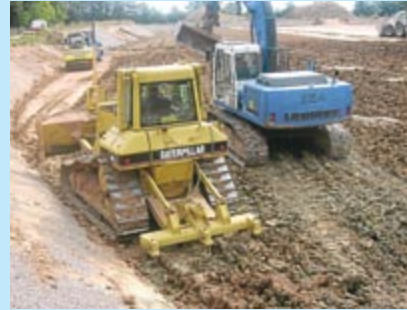
Fräsen, Planieren und Verdichten der oberen Lage der geologischen Barriere.
