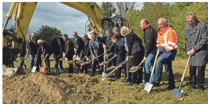
Mit großer Freude haben alle am Bau der Ortsrandstraße Faulbach beteiligten Politiker und Behördenvertreter den ersten Spatenstich vorgenommen.
