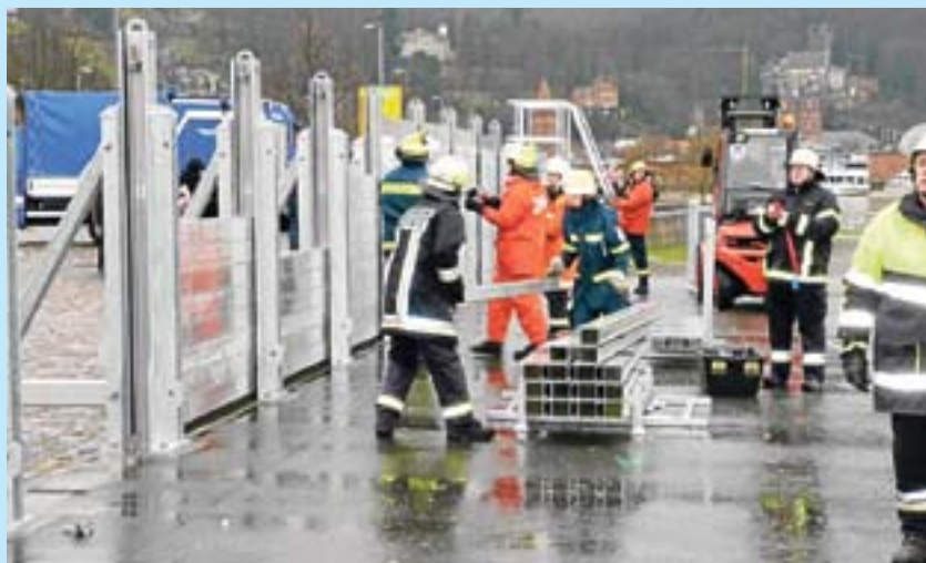
Aufbau der Hochwasserschutzmauer in Miltenberg
