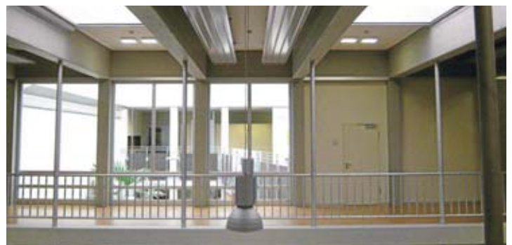
Aula mit Deckenstrahlheizung.
