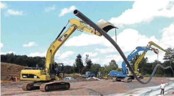
Verlegung Sickerwasserdrainageleitung.
