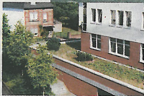
Photovoltaikanlage Realschule Oberburg und Dachbegrünung Landratsamt
