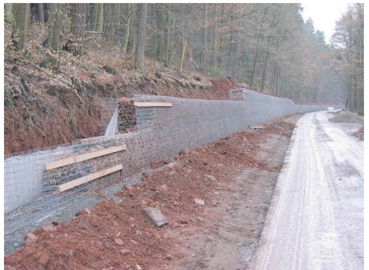
Aufgrund der Topographie sind zur Hangsicherung Stützwände, sogenannte "Gabione", notwendig.
