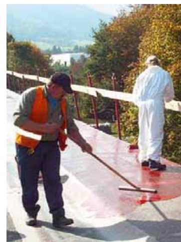
Sanierung der Mainbrücke Großheubach - Kleinheubach.
