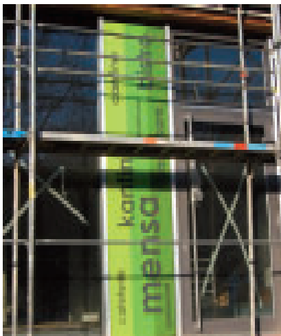
Die neue Fassade der Mensa blitzt schon hinter dem Gerüst hervor.
