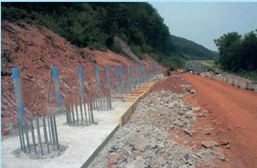
Im Kopfbereich freigestemmte, einzelne Bohrpfähle werden im nächsten Arbeitsgang mit einem Betonbalken verbunden. Im Hintergrund senkrecht angeordnete Entwässerungsröhre (blau).
