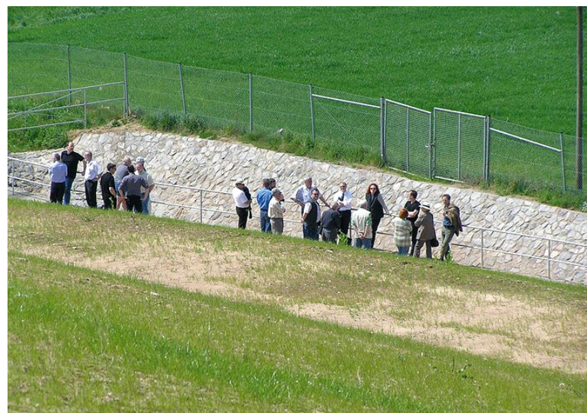
Führungen über das Deponiegelände mit entsprechenden Erläuterungen zur Abdichtungsmethode wurden für die Besucher durchgeführt.
